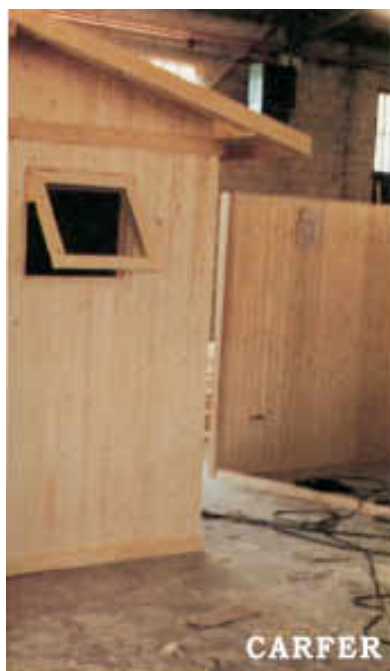
Sauna aislada. Tienen menor peso y suele construirse en terrazas o lugares resguardados (Tablones verticales)
