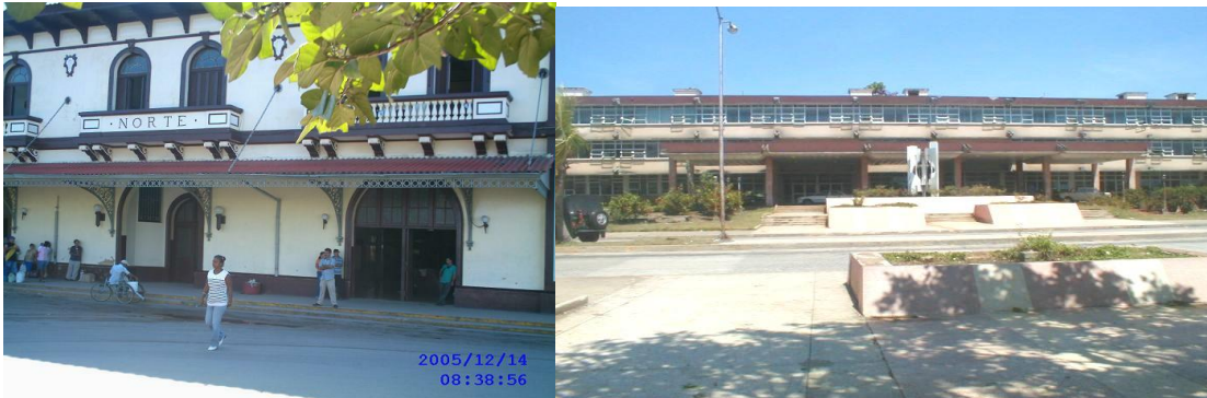
Estación de ferrocarriles y Hospital "Roberto Rodríguez" Morón. (Morón's station and Morón General Hospital).
